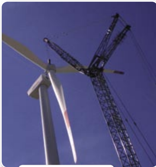
Schwebende Lasten: Ein Großkran hieft den Rotor zur Gondel
